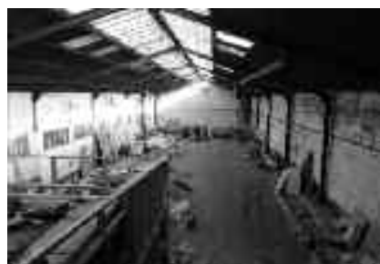
Vue de la NEW SPACE pendant les travaux de rénovation, Liège, mai 2020
