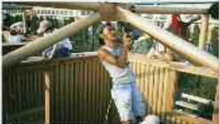
Shigeru Ban, *Paper Log house*, 1995. Caisses de bière, sable, tubes en carton de 4mm d'épaisseur, toile de tente, surface au sol de 16 m<sup>2</sup> Kobe, Japon.
